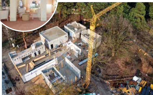
Stan budowy na 15 marca 2024 r.
